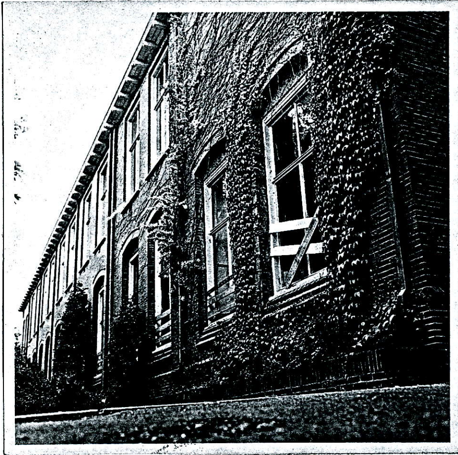
De latere Oorsprong vlak voor de sloop.
