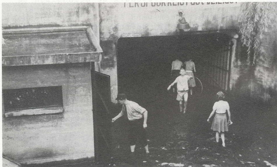
21-7-1950. Overstroming in de voetgangerstunnel. J.v.Dijk voor het pomphuis.
