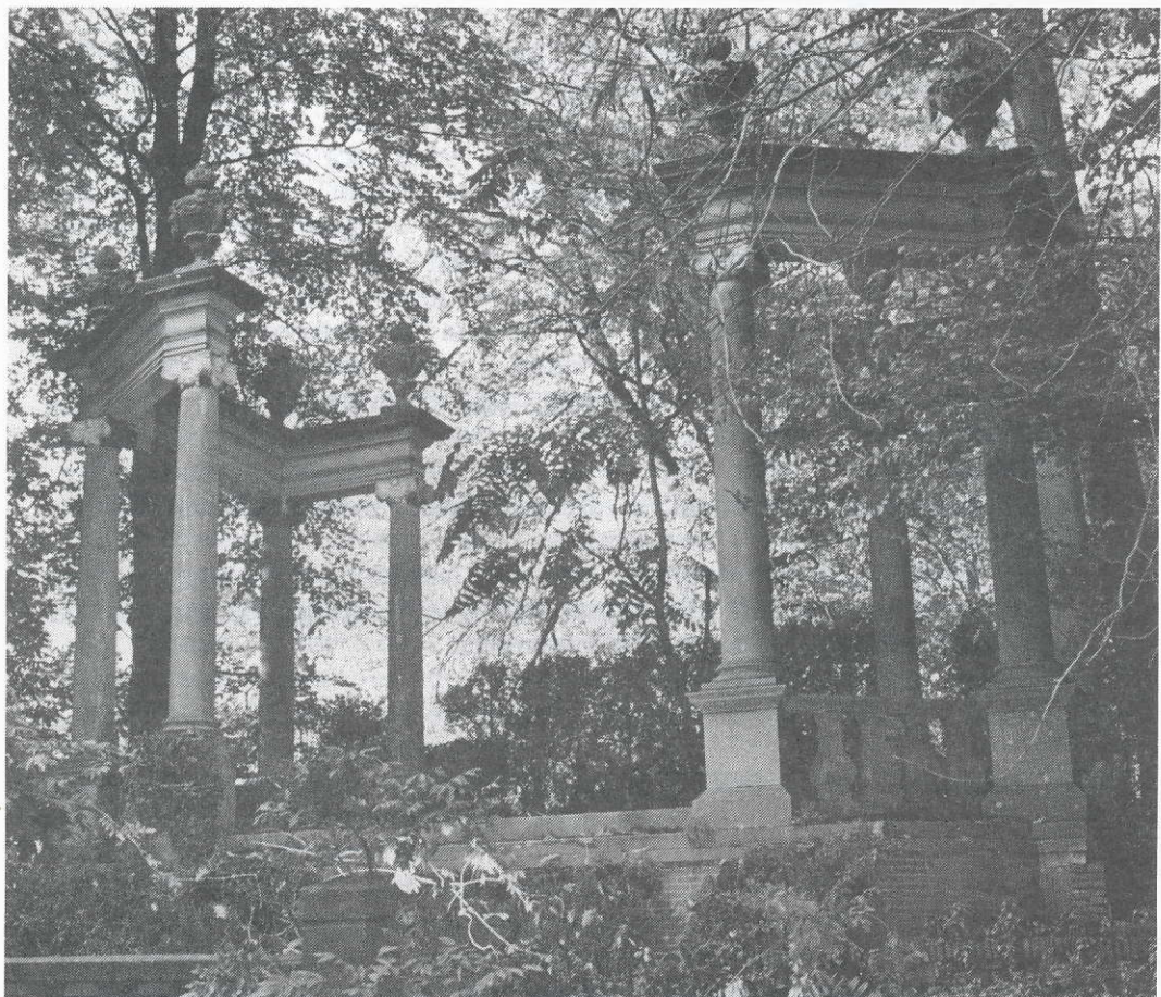
De achterkant van de colonnade in het Baarnse Cantons Park. De leuning en de balusters zijn wegens bouwvalligheid verwijderd. De siervazen moeten hersteld worden. okt. '92.
