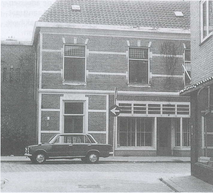
Situatie in 1972: dit huis zou later wijken voor de bouw van het pand waarin nu 'C1000' is gevestigd
