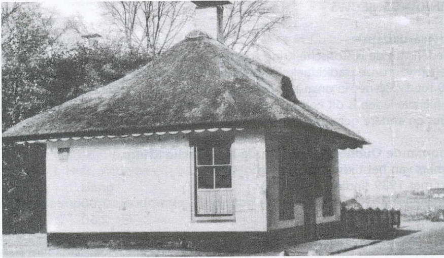
Het tolhuis aan de Eemweg, vóór en tijdens de sloop in 1958 Het is te hopen dat een dergelijk 'vandalisme' nooit meer zal plaatsvinden
