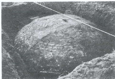
De bovenzijde van de put met op de voorgrond de natuurstenen plaat waarachter het aanvoergat zit
