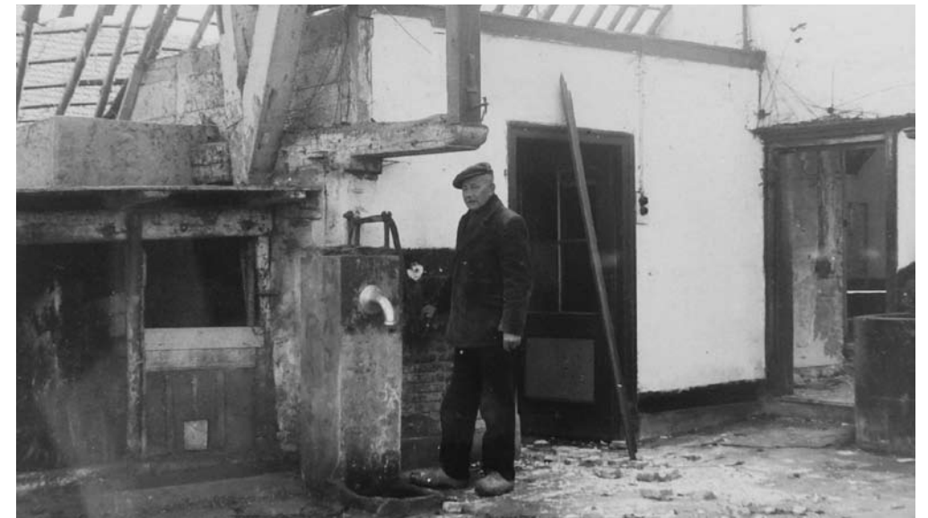
Jan de Ruijter in de al half gesloopte boerderij aan de Zandvoortweg
