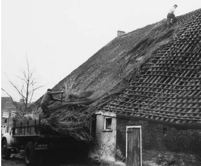
Sloopwerkzaamheden aan een boerderij aan de Zandvoortweg
