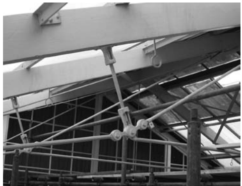
Afb 3. De houten spanten en de ijzeren stangen
