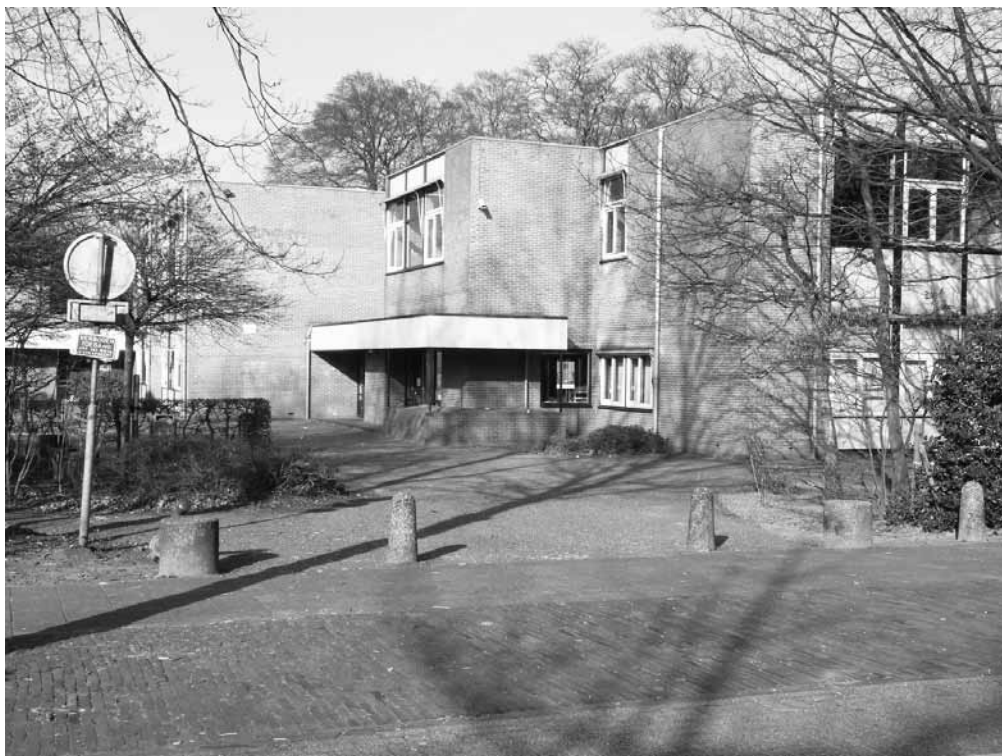
De huidige situatie bij het leegstaande Waldheimmavo schoolgebouw, zonder pijlers.
