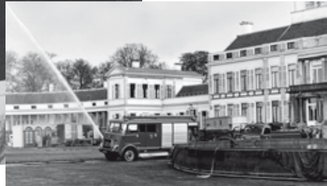
De brandweer bij het paleis
