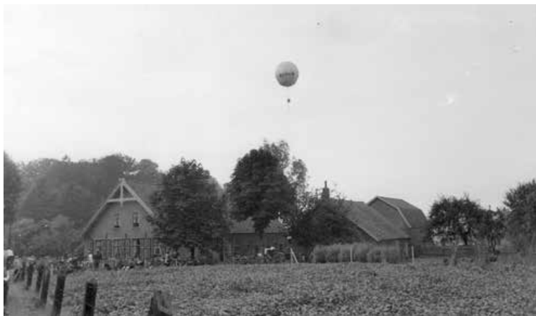
Joris Zonneveld en zijn echtgenote Marijtje Ramp waren de eerste 'Zonnevelden' die de boerderij op Zandvoortweg 254 in Baarn bewoonden. Het pand is in 1855 gebouwd, dat jaartal stond met grote cijfers op de voorgevel. Oorspronkelijk heette de boerderij De Koekoek. Hun zoon Gerbrand heeft hier later ook nog 22 jaar gewoond.
