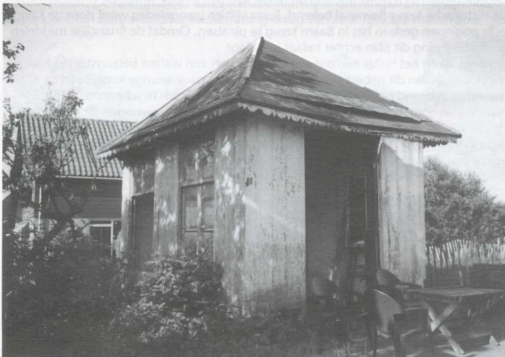
Een recente foto van het huisje aan de Eemdijk in verwaarloosde toestand. Eens wachtten hierin de reizigers op de postkoets naar Amersfoort en Amsterdam.
