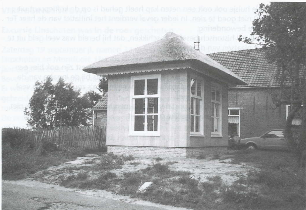
Het nieuwe wachthuisje aan de Eemdijk nr. 18, een nauwkeurige kopie van het origineel uit ongeveer 1830
