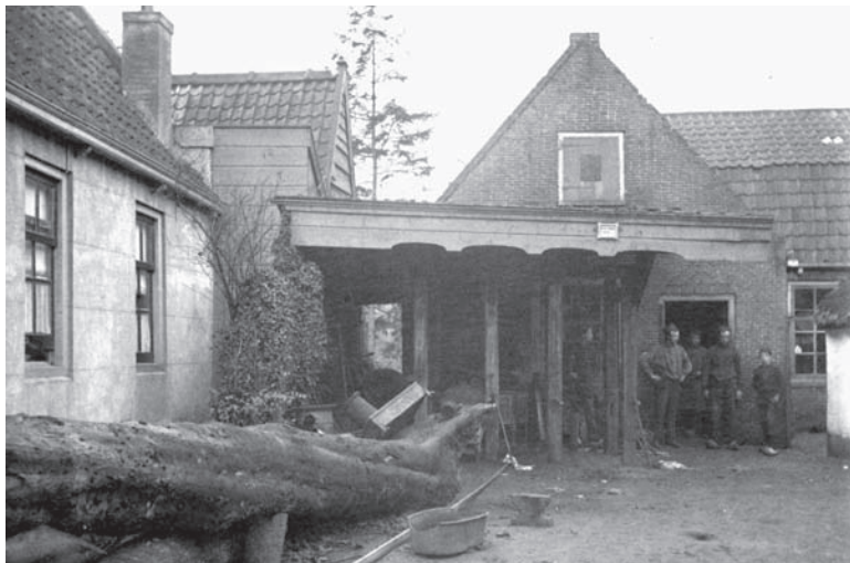
Afb. 6. De smederij van Brulleman eind 19e eeuw. Voor de smidse zien we een hoefstal of travalje, een houten stellage waarin een paard werd beslagen (d.w.z. een nieuwe hoefijzer van de smid kreeg). (Coll HKB)
