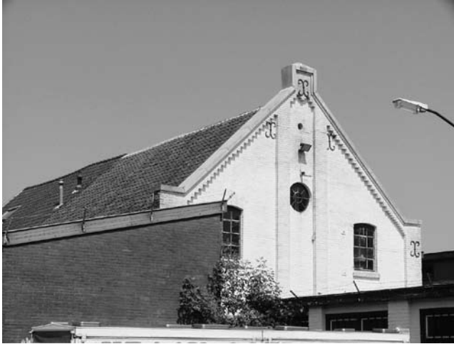
Afb. 2: De achtergevel is nog origineel
