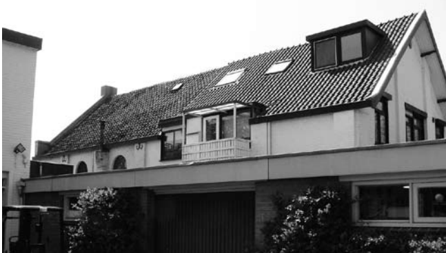
Afb. 3: Links zijn de originele ramen en muurankers nog zichtbaar
