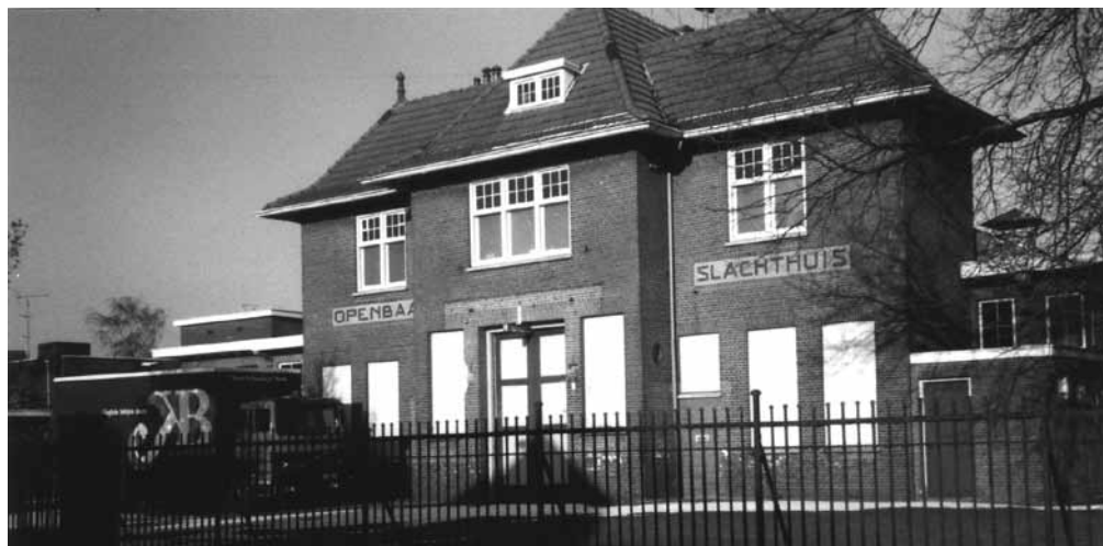
Het slachthuis dichtgetimmerd, wachtend op sloop.
