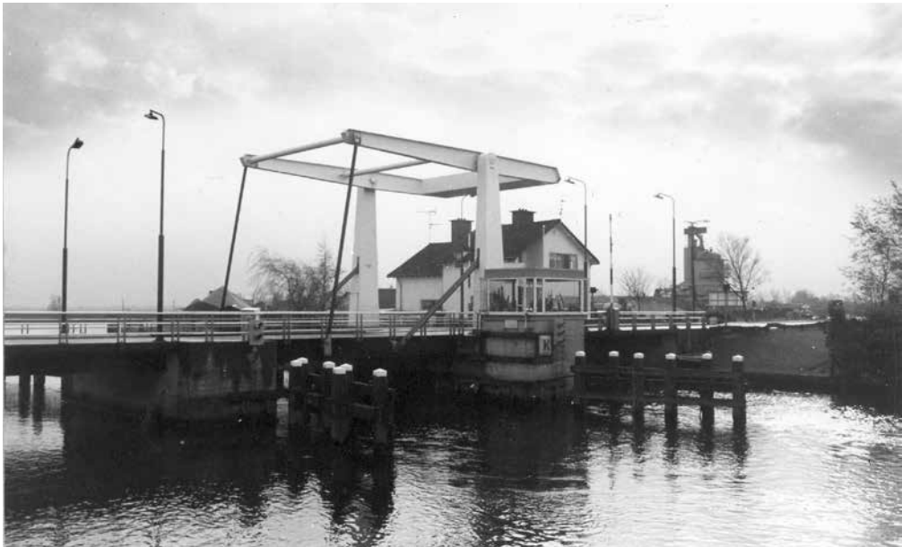
De nieuwe brug. Hier nog zonder fietsbrug ernaast. (HKB)
