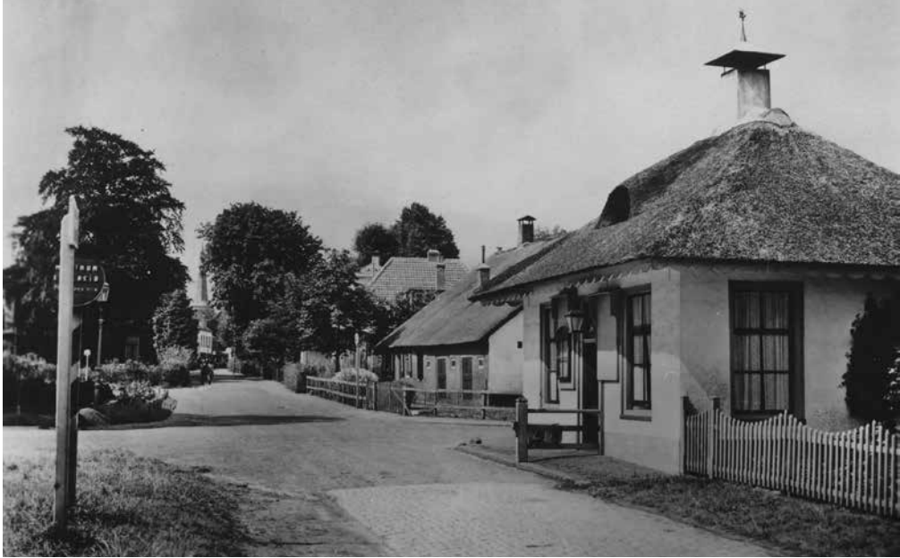
Zicht vanaf de Eemstraat richting de Brink Hier de Hoofdstraat met op de achtergrond de kerktoeren van de Pauluskerk aan de Brink. Achter het tolhuis de boerderij van Paridon. Het tolhuis is in 1970 afgebroken ter verbreding van de Eemweg.
