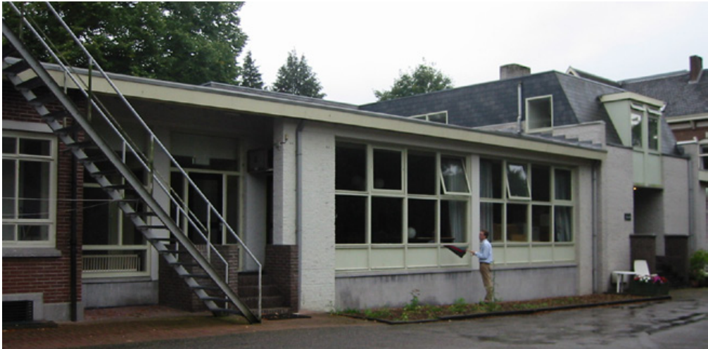
Middenstate, medio de jaren 1980 gebouwd en jarenlang de verbinding tussen Hoofdstate en Hoekstate.
