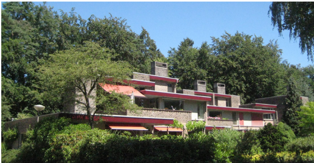
Het appartementencomplex Uytenbosch in 2018 (foto auteur).
