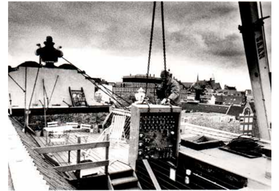
Afb. 11. Een medewerker van Liftenfabriek 'Baarn' is bezig met het installeren van een lift via het dak van een pand aan de Oudezijds Voorburgwal in Amsterdam, ca. 1985. (Archief familie Van Ommen)
