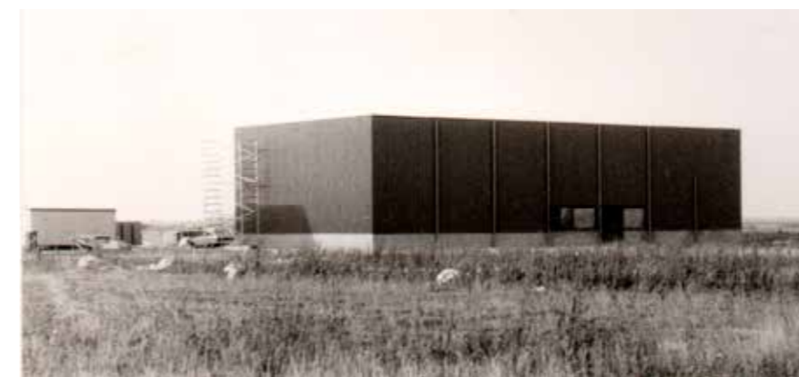
Afb. 12. De nieuwe bedrijfsruimte van Liftenfabriek 'Baarn' in Almere, in aanbouw, 1980. (Archief familie Van Ommen)
