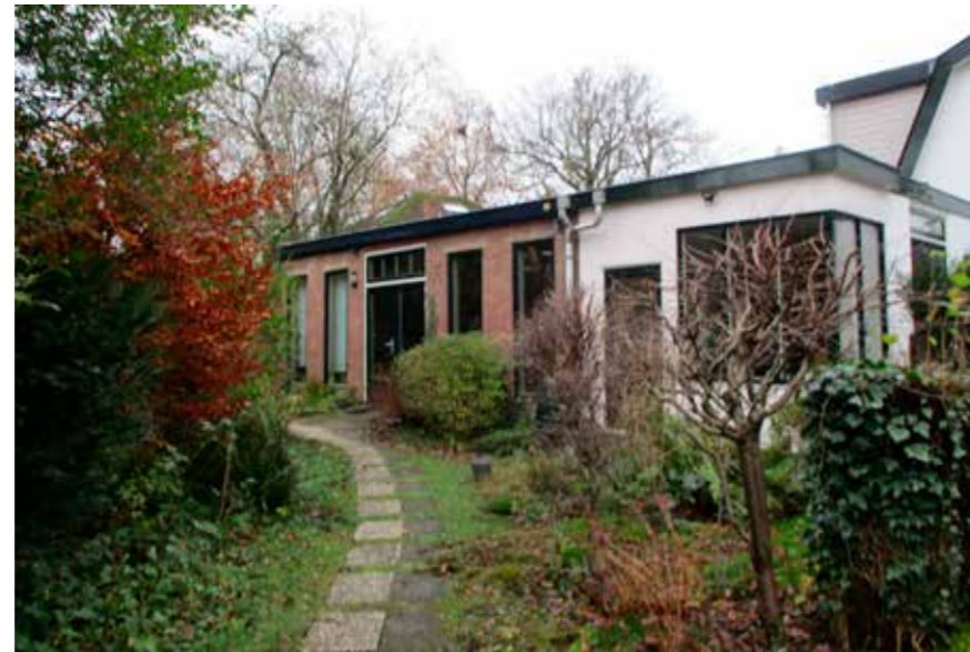
Afb 10. De door Van Ommen aangebouwde fabrieksruimte met rechts het kantoor van de Liftenfabriek 'Baarn' naast het woonhuis, Van Heemstralaan 5, 2023. (Fotograaf: Willemijn Booy-de Jongh)
